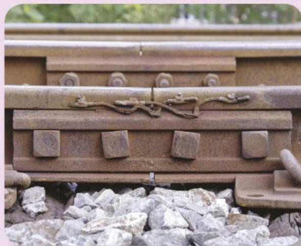
La junta de dilatación está determinada por el material, la longitud de los rieles y la diferencia de temperaturas a la que están expuestos.
