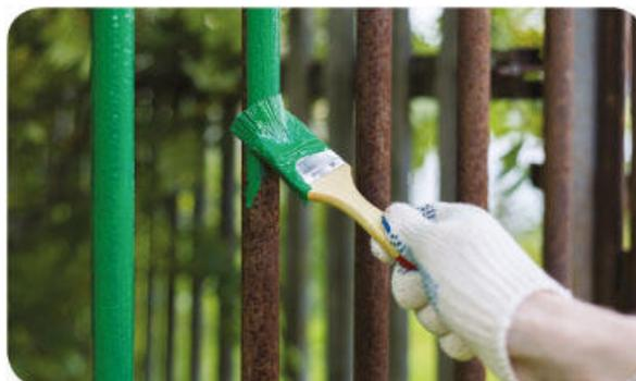
**Figura 1.42** Para evitar el deterioro del hierro en estructuras de uso cotidiano, es necesario recubrirlo con materiales resistentes a la corrosión, como la pintura y el barniz.
